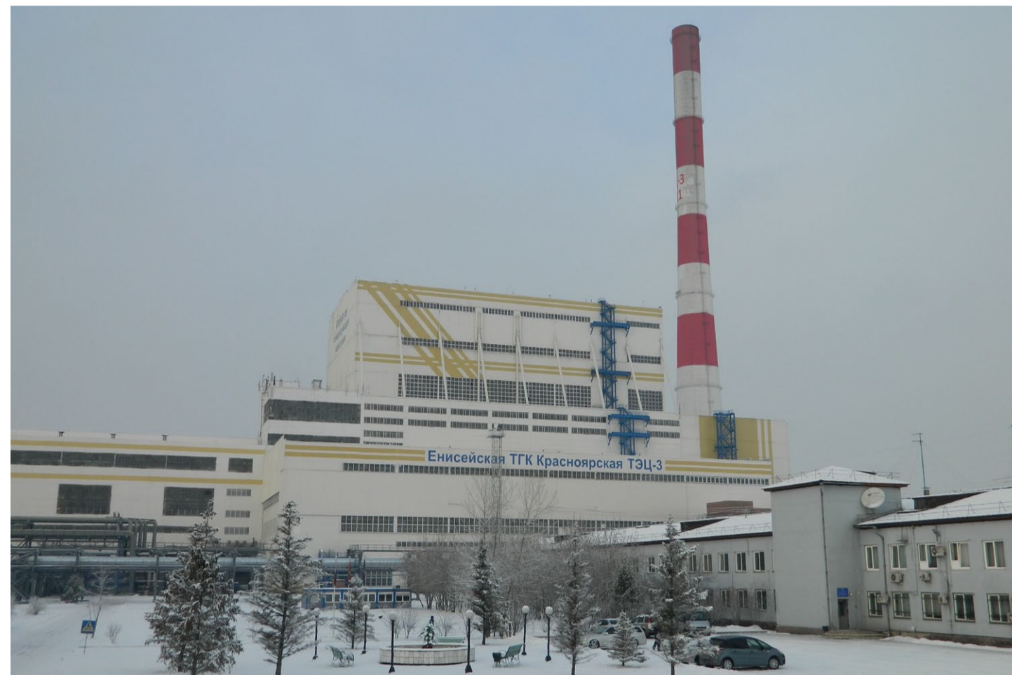
На Красноярской ТЭЦ-3 начались комплексные испытания нового энергоблока. А в марте 2012 года энергоблок будет введен в промышленную эксплуатацию.
