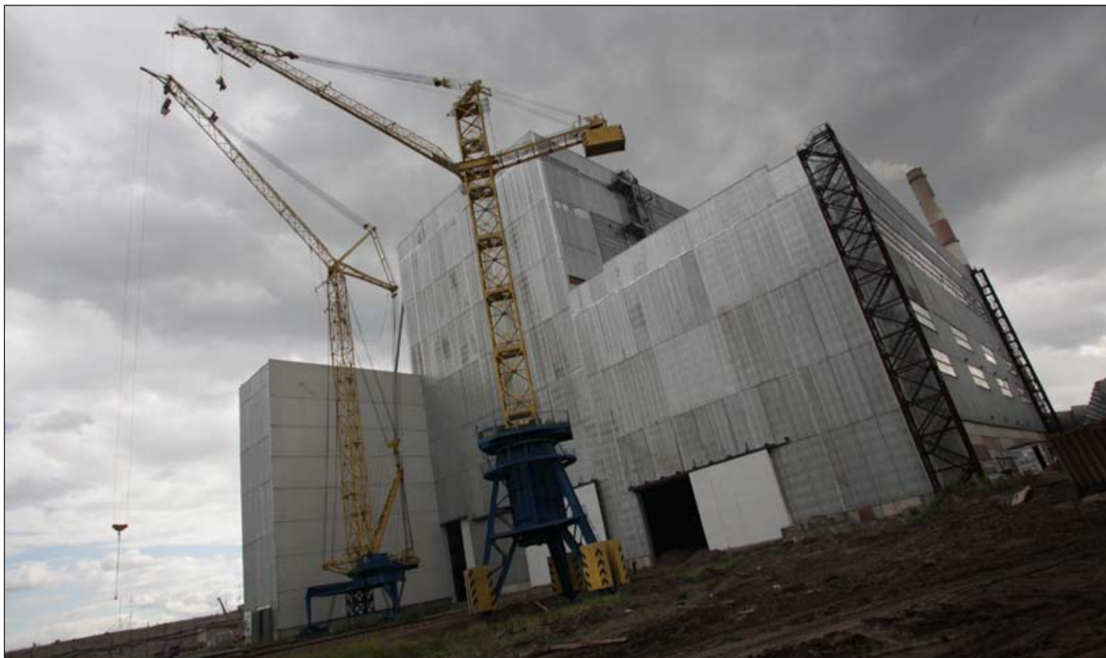
Будущий корпус Красноярской ТЭЦ-3.
